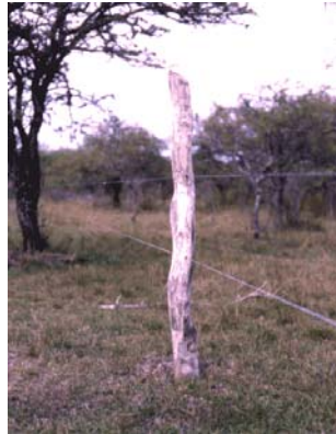
Alambre eléctrico con postes y dos hilos sin aislador en campo natural.
