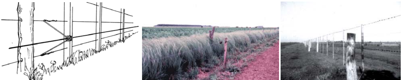
Figura 30.- a)-Protección de alambrados convencionales fijado en el mismo alambre. b)-Eléctrico construido con medios postes protegiendo a un alambre tradicional en muy mal estado. c)-Eléctrico construido con medios postes para evitar que las vacas amamenten a sus terneros destetados a través del alambre.
